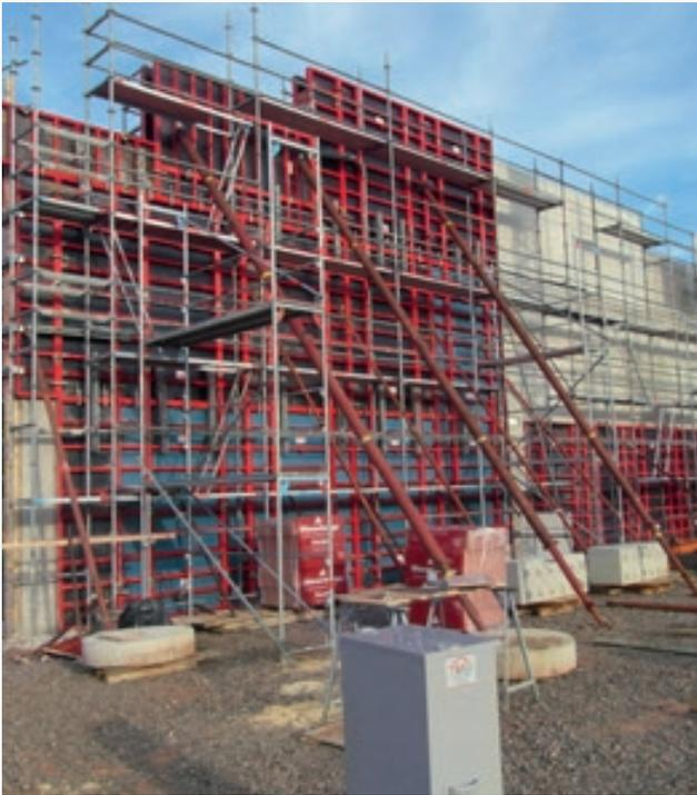
Das Grundelement der **FORMAS** mit 135 cm Breite und dem geringen Ankerstellenanteil garantiert kurze Schalzeiten und hilft Kosten zu sparen. Das Ergebnis zeigt sich durch wenig Stoßfugen und Ankerlöcher im Betonbild. Das logische und leicht verständliche Schalungssystem ermöglicht ein schnelles, rationelles und wirtschaftliches Arbeiten.
